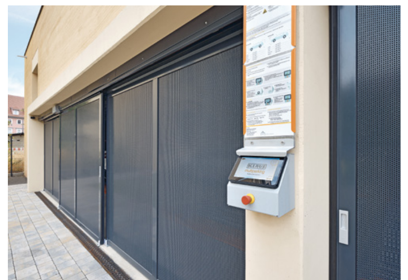
Durch Berührung oder Befehlseingabe am Touchscreen wird der angewählte Stellplatz in Position gebracht.
