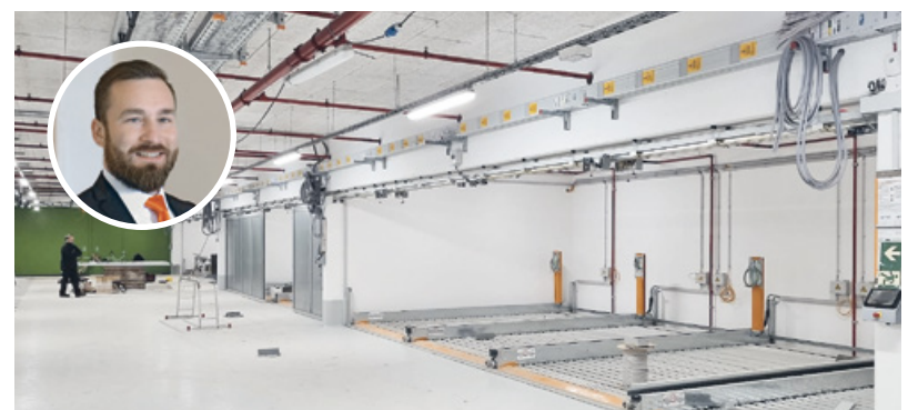
Besondere Herausforderung, stark gemeistert: Die Installation der Parksysteeme in der Berliner Vattenfall-Zentrale verlief parallel zu weiteren Bauarbeiten. Links im Bild: Projektmanager Thomas Flaig.
